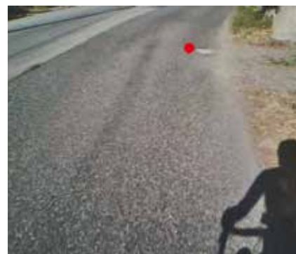
10. Fissazione sul punto a margine della buca che costituirà parte della traiettoria
